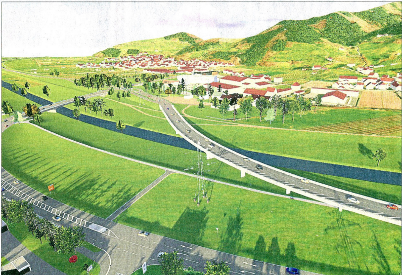
So soll die Haslach-Umfahrung aussehen. Eine neue Brücke führt die Bundesstraße über die Kinzig und auf den bestehenden Damm. Links im Bild die bestehende Brücke, über die man aus Richtung Offenburg bisher nach Haslach einfährt. Animation: Regierungspräsidium
